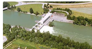
Centrale di Flumenthal (21.7MW), CH
